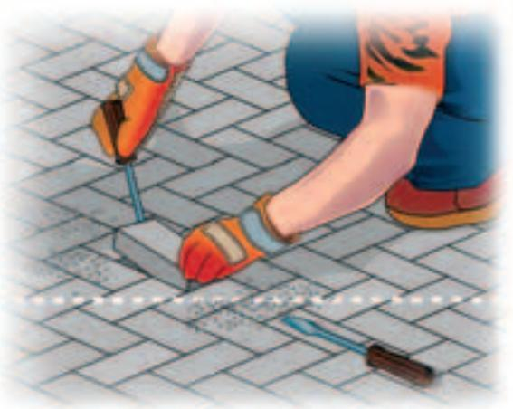
Nel caso in cui la pavimentazione sia stata sottoposta a traffico veicolare per un lungo periodo di tempo e la sabbia tra i giunti abbia sviluppato una completa azione autobloccante, potrebbe non risultare possibile estrarre il primo massello nel modo precedentemente indicato: in tal caso sarà necessario romperlo con martello e scalpello (Figura n. 2.6): generalmente non è necessario ricorrere a un martello pneumatico.
