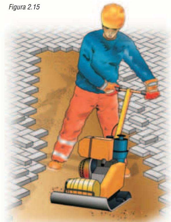
Nella determinazione delle quote finite si deve tenere presente che, per effetto della compattazione, ci sarà un calo di spessore della sabbia del 20÷30%; il piano di riferimento per determinare lo spessore finale dello strato di allettamento è pertanto la quota di base dei masselli indisturbati.
