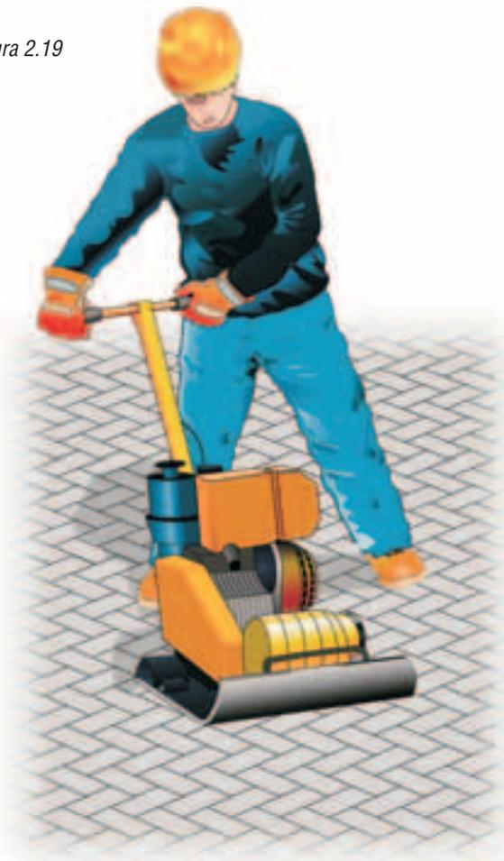
Si completa infine l'intasamento con una seconda e definitiva stesura e spazzolatura di sabbia di sigillatura, verificando la perfetta saturazione dei giunti.
